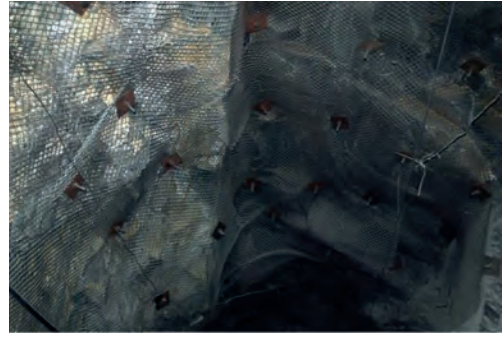
Рис. 2. Повторное крепление выработки анкерами и сеткой Fig. 2. Second reinforcement of excavation with rock bolts and mesh
